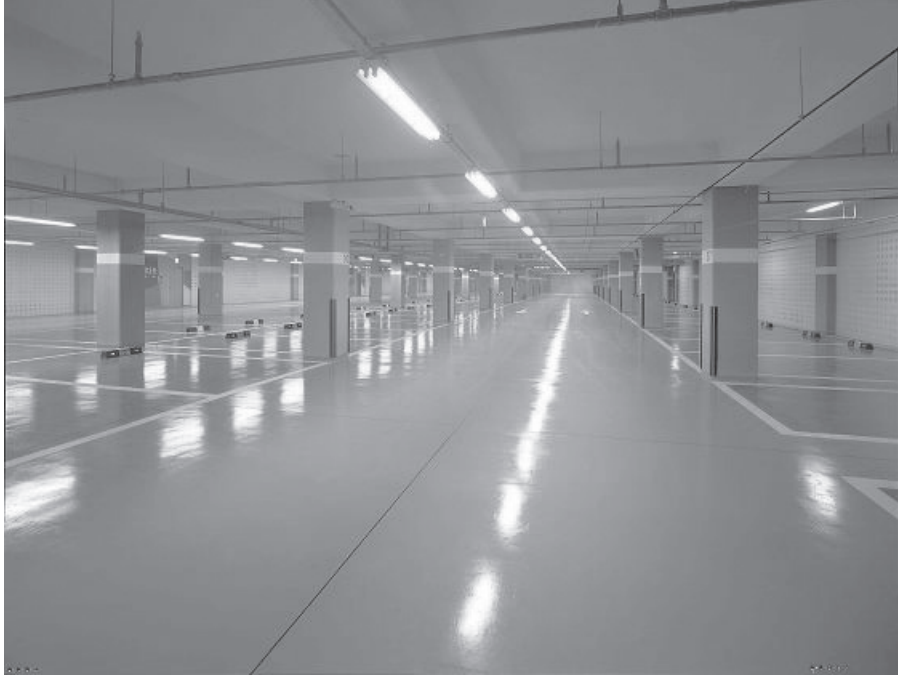
▲쌍용건설(주)이 아파트 리모델링 사상 국내 최초로 시공한 지하주차장
