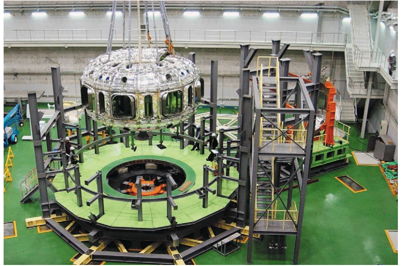
사진1 진공용기와 열차폐체의 현장 설치 모습
