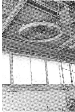
〈그림3〉 인버터방식의 송풍팬 ⇒ 남은 사료의 건조효과를 중시하여 직하식으로 설치되어 있다.
