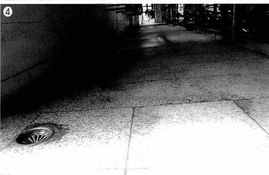
①, ② 원유탱크실 ③ 착유실의 내부모습 ④ 착유실 바닥재는 착유우와 작업자의 낙상을 방지하도록 거친재질의 타일을 사용한 것이 특징이다.
