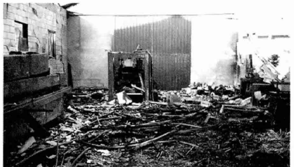
● 사진 3 ● 블록 구조의 작업장 내부 소손 흔적
