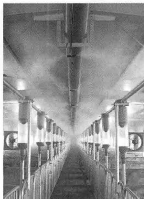
〈사진 7〉 예비사에서부터 검정사, 심사대기사, 경매대기사 등 전돈사에 하절기에는 냉방(농업용전기), 동절기에는 난방(등유)이 가능한 4계절 냉·온풍기 설치로 계절변화에 따른 스트레스 해소 및 호흡기 예방을 기대할 수 있다. 또한 음이온이 발생해 돈사내에 불어줌으로서 실내환기 개선효과를 통해 쾌적한 환경유지가 가능하다.
