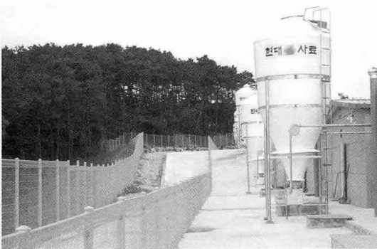
〈사진 5〉 고양이, 야생설치류 등에 의한 질병유입을 막기위해 간격이 좁은 코팅외곽막을 검정시설 전 경계지역에 설치하였다. 또한 사료 차량, 난방류, 기타 외부차량은 2개소의 소독조 통과를 물론 검정시설 접근을 막기 위해 장내 외부차량 전용도로를 시공하고 이용하게 하였다. 이렇게 2중웬스를 설치하여 접촉감염에 의한 질병 유입을 원천 차단하고 차단방역에 의한 청정화가 가능토 록 시공하였다.
