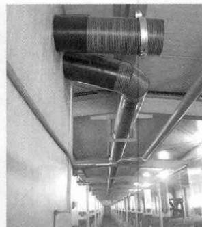
〈사진 7〉 예비사에서부터 검정사, 심사대기사, 경매대기사 등 전돈사에 하절기에는 냉방(농업용전기), 동절기에는 난방(등유)이 가능한 4계절 냉·온풍기 설치로 계절변화에 따른 스트레스 해소 및 호흡기 예방을 기대할 수 있다. 또한 음이온이 발생해 돈사내에 불어줌으로서 실내환기 개선효과를 통해 쾌적한 환경유지가 가능하다.
