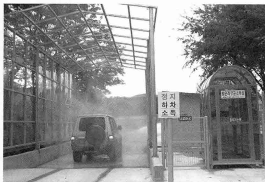
〈사진 2〉 차단방역을 위해 방역 및 위생수준 향상을 위해 1차소독조(대인·차량소독조), 2차소독조(차량·인체 소독조)의 2개소에 소독을 거치지 않으면 장내 진입이 불가능하도록 시공하였다. 사진에서 보는 바와 같이 방문객은 일단차량 정지후 우측에 보이는 방문객 무균소독실(들어가는 곳)을 통과후 왼쪽(나오는 곳)철문으로 나온다. 그 후 다시 차량에 탑승 후 차량소독조를 통과하여야만 장내로 진입이 가능하도록 시공하였다.
