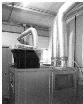
〈사진 7〉 예비사에서부터 검정사, 심사대기사, 경매대기사 등 전돈사에 하절기에는 냉방(농업용전기), 동절기에는 난방(등유)이 가능한 4계절 냉·온풍기 설치로 계절변화에 따른 스트레스 해소 및 호흡기 예방을 기대할 수 있다. 또한 음이온이 발생해 돈사내에 불어줌으로서 실내환기 개선효과를 통해 쾌적한 환경유지가 가능하다.
