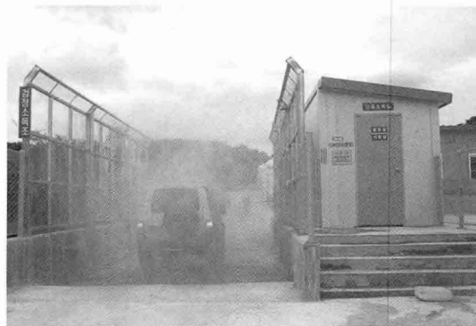
〈사진 2〉 차단방역을 위해 방역 및 위생수준 향상을 위해 1차소독조(대인·차량소독조), 2차소독조(차량·인체 소독조)의 2개소에 소독을 거치지 않으면 장내 진입이 불가능하도록 시공하였다. 사진에서 보는 바와 같이 방문객은 일단차량 정지후 우측에 보이는 방문객 무균소독실(들어가는 곳)을 통과후 왼쪽(나오는 곳)철문으로 나온다. 그 후 다시 차량에 탑승 후 차량소독조를 통과하여야만 장내로 진입이 가능하도록 시공하였다.
