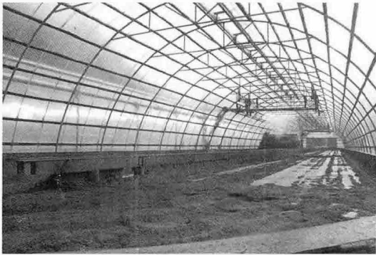
▲ 지붕은 태양열의 효율적인 이용을 위해 햇빛을 투과할 수 있는 재질을 사용하여 수분증발효율을 높였다. 퇴비의 질은 수분함량에 따라 큰 차이를 보인다.
