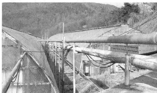
▲ 지하저장조에 모아진 분뇨는 각 퇴비장에 연결되어진 파이프를 통해 펌프로 끌어올려 각 1, 2동 퇴비발효장으로 이동되어진다.
