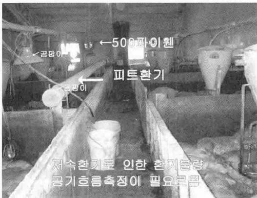
<그림 8> 환기불량으로 발생한 곰팡이 사진
