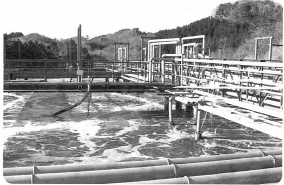
▲ 자연순환농업의 성패는 경종농가가 안심하고 사용할 수 있게끔 양질의 퇴·액비 생산에 노력하느냐에 달려 있다. 자연순환농업이 단지 양돈농가의 어려움 해결을 위한 수단이 아니라 농업의 건전성 확보를 위한 새로운 성장 동력으로 자리매김하길 기대한다.
