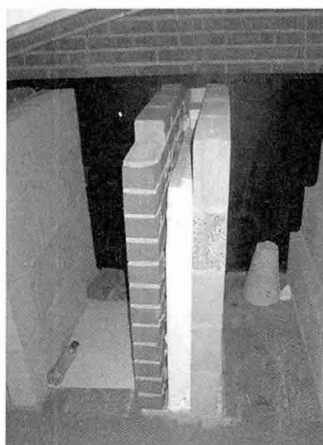
<그림 6> 네델란드 돈사벽체구조, 벽돌사이에 스티로폼 방습제를 설치했다. 국내에서도 방습제를 첨가해야 한다.
