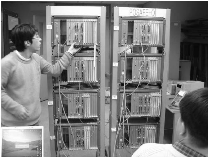
<그림 2> PLC 계통 시험 장면
