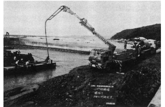
사진 8.2.1 콘크리트 펌프에 의한 타설상황
