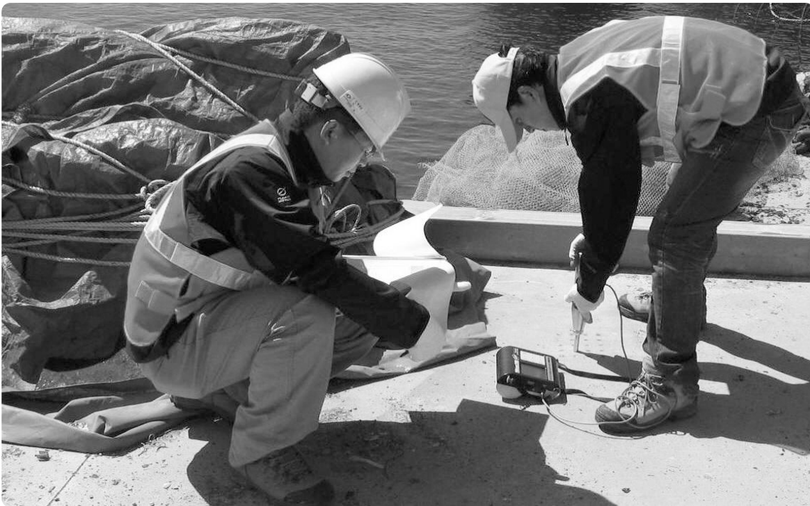
▲ 한국어촌어항협회 점검요원이 어항시설물 콘크리트 강도를 측정하고 있다.
