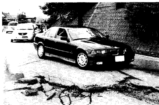
사진 2. 일반 시내도로의 파손
