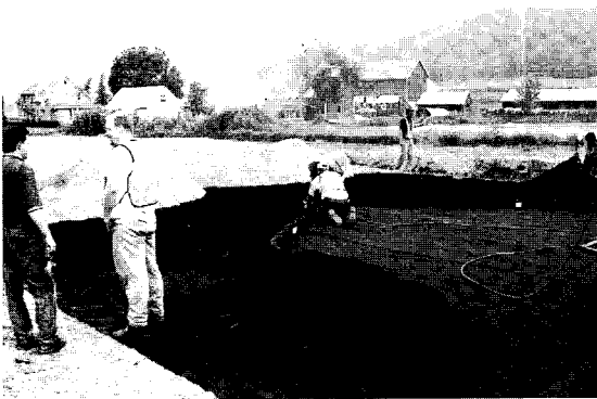
그림 2. Geocell 과 Foundry slag 시공 (Edil et al., 2002)
