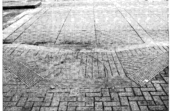
그림 7. 횡단보도 진입부의 미끄럼방지 시설
