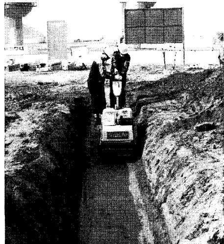
그림 5. 핸드롤러를 이용한 모형지반 다짐
