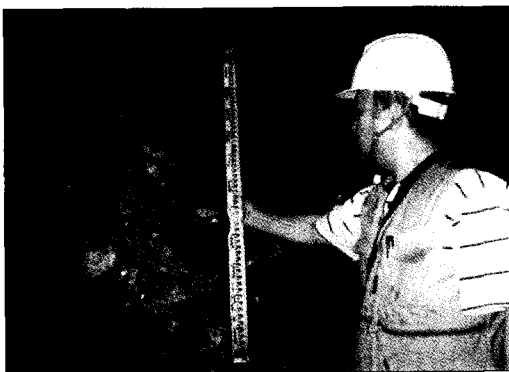
그림 6. 시험시공한 수평제트 그라우팅 구근의 조성상태 확인
