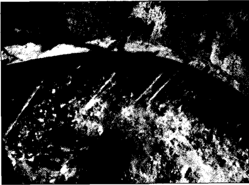
그림 7. 터널 천단에 노출된 수평제트 그라우팅 구근 및 강관
