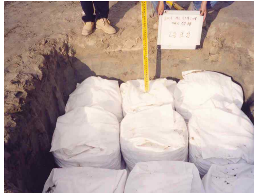
그림 5. 굴폐각 충전 게비언 설치.
