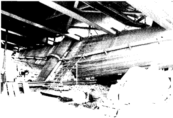
〈Photo 1〉 Collapsed Pier
