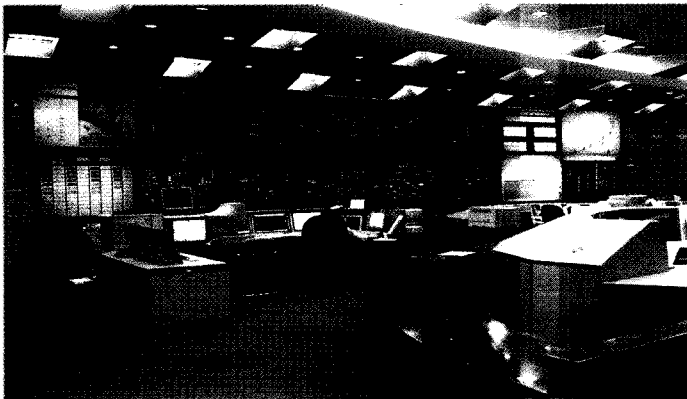
[전력거래소 중앙급전소 전경]
