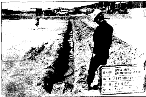
(a) 진공부압계 설치
