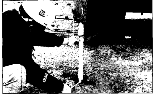
그림 6. 파라오름(실타입철선) 확인 및 연신을 확인
