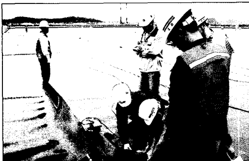
그림 12. 진공막 시공관리 (용접 및 공기압 시험)
