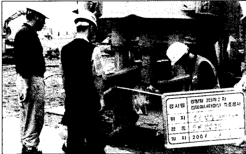
그림 9. 진공차단거(S.C.B.W) 시공관리(장비 반입 및 안정액 품질검사)
