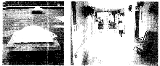
사진 8. 시스템 및 태양광 유입
