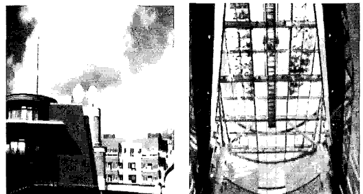
사진 12. 시스템 및 태양광 유입
