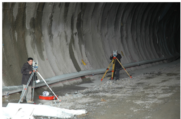
그림 12. 타겟부착 토탈스테이션에 의한 변위 계측
