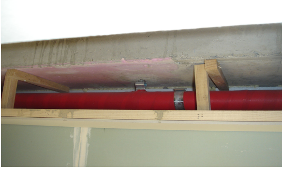
사진 2. 스프링클러설비 설치 세대 천장구조 시공장면
