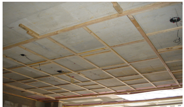
사진 1. 스프링클러설비 미설치 세대 천장구조 시공장면
