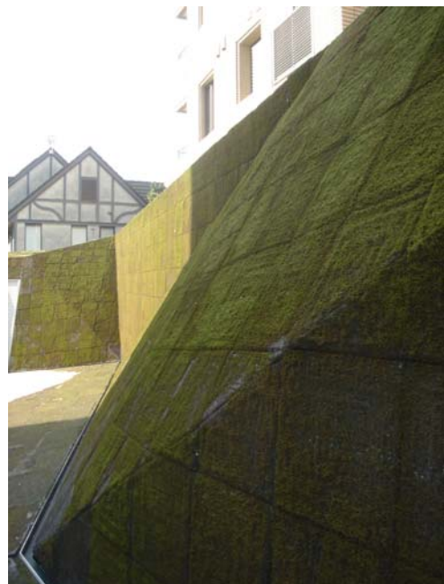
그림 10. 동경 프라다 사옥 옹벽면 [출처: 김용규 촬영]
