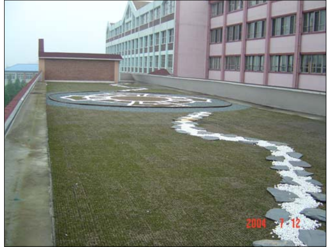
그림 9. 인천박문여고 옥상 시공사례 [출처: 김용규 촬영]
