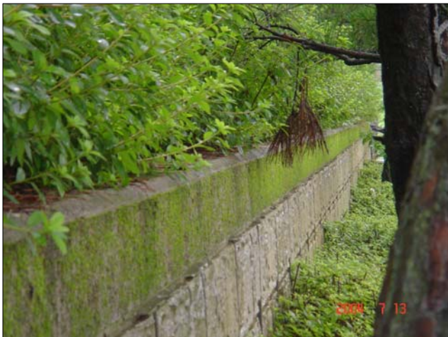
그림 12. 곤지암CC 주차장 옹벽 상단
