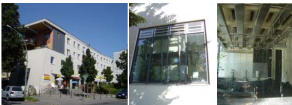
Lankwiz 주거단지 우수정화시설 설치
