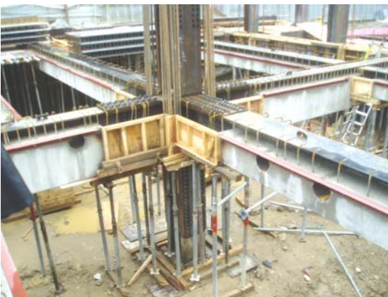
그림 15. 기둥-합성보 접합부 시공현황
