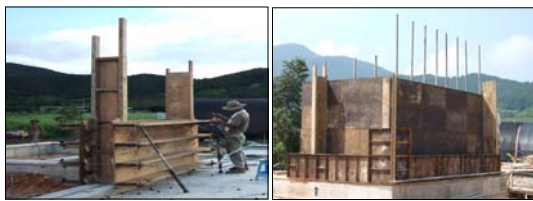
a) 합판거푸집 b) 유로폼 그림 2. 합판거푸집과 유로폼
