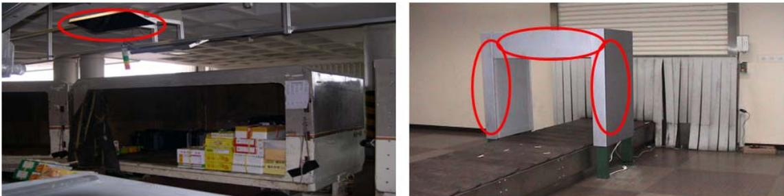
그림 11. 수하물처리영역 및 도착지역 RFID System의 실제 설치 예 (아시아나 IDT제공)
