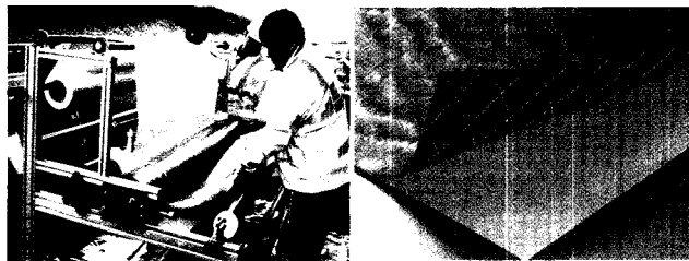
(a) 습식 현장 시공시스템(기계함침)
