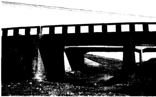
(a) 교량 전경
