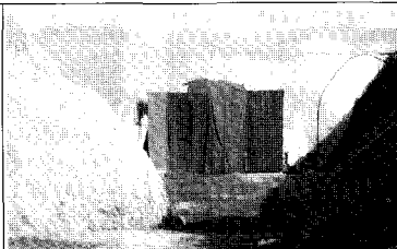
부직포를 이용한 이동식 방음시설
