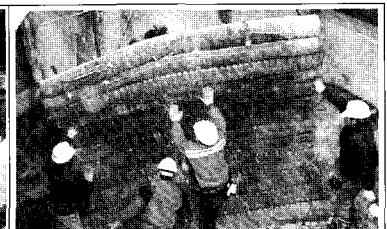
타이어매트를 이용한 이동식 방음시설
