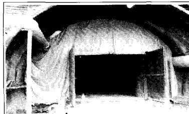
솜크리트+방음판넬+천막을 이용한 고정식 방음시설
