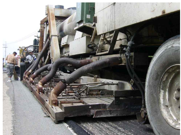
[그림 11] 현장가열 재생 포장 설비
