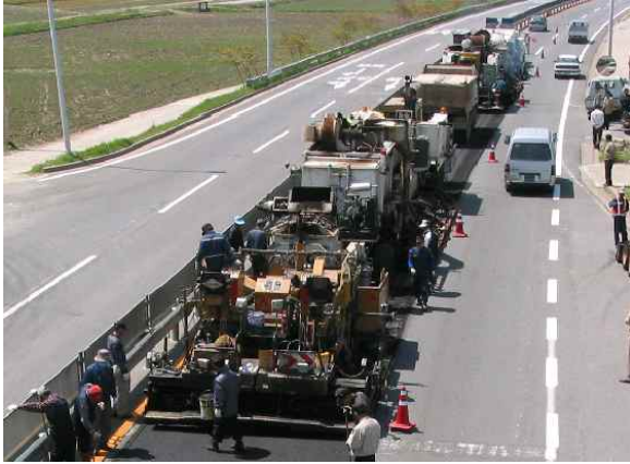
[그림 12] 현장가열 재생 포장 시공장면
