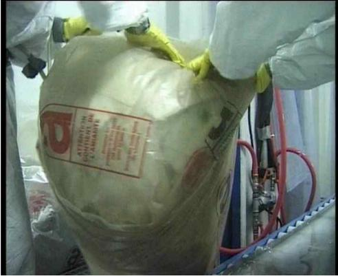
[그림 18] 폐석면 뿔철제의 포집 및 포장
