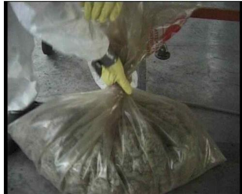
[그림 17] 폐석면 뽕칠재의 포집 및 포장
