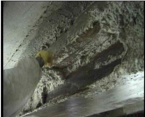
[그림 16] 뽕칠재에 수분의 분사 및 수작업에 의한 뽕칠재의 제거
