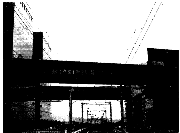
<그림 1> Sky Bridge 전경
