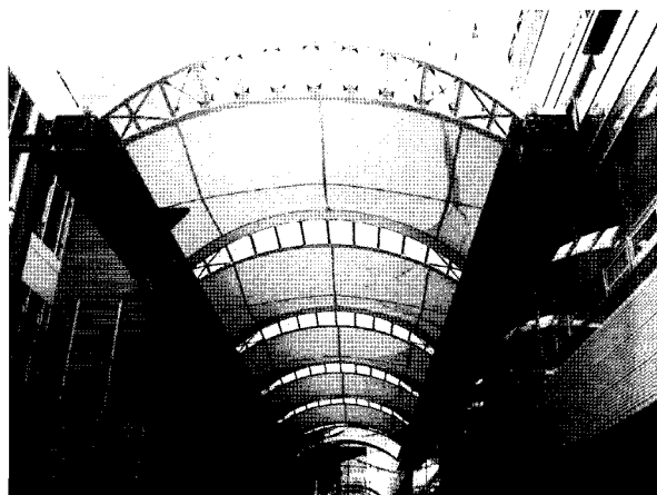
〈그림 10〉 RS-08막 설치 내부전경
