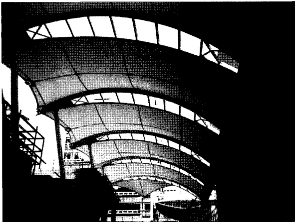
〈그림 9〉 RS-02 막 설치 내부전경
