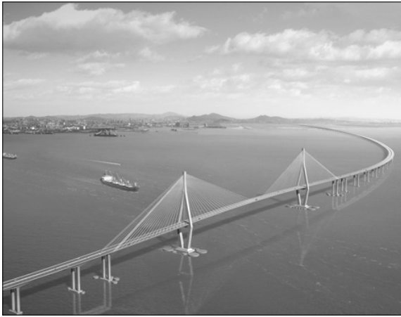
그림 2. 2009년 완공을 목표로 시공 중인 인천대교
