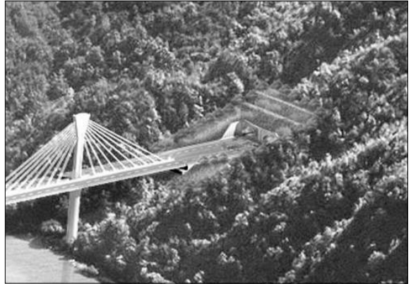
그림 6. 특수교량과 인접한 근접병설터널의 합리적인 선형 계획을 구현한 남후터널
