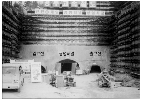
그림 7. 광명터널 및 입·출고선 시공 전경
