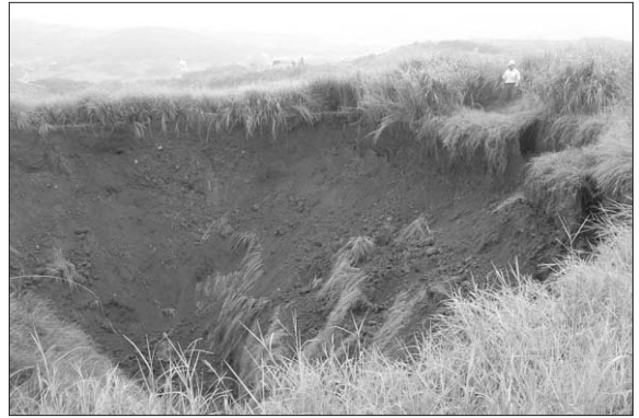
그림 23. 대만고속철도 터널 상부 지표 함몰 전경
