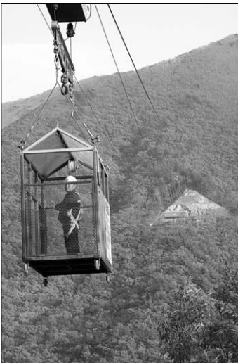
그림 8. 수직갱 시공을 위한 삭도 (Cableway)
