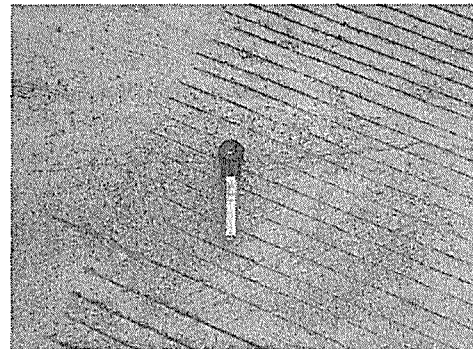
(b) 균열폭 측정
