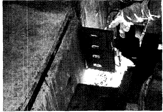
그림 18. Shear tab 용접시 비산방지대
