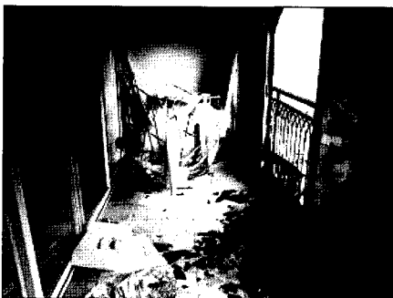
[그림 9] 화재발생 세대 직상 층의 발코니 화염피해
