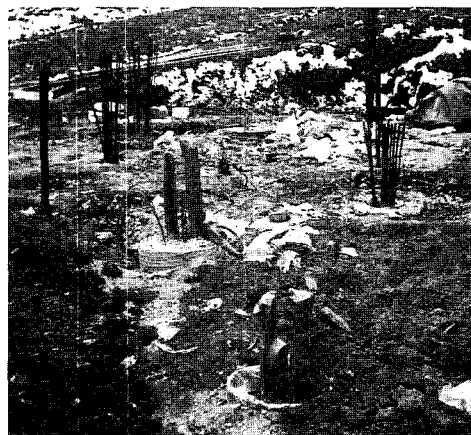
그림 2. 1/8시험체 및 시공 후 모습
