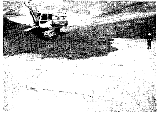
(b) 감지기 설치 후 매립
