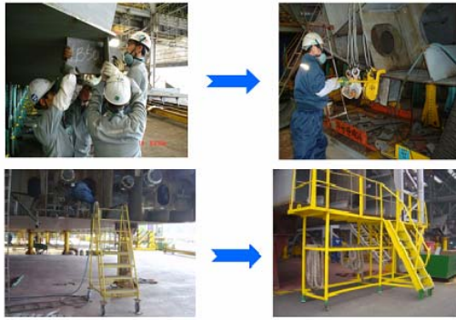
a) LUG취부 JIG개발 b) 작업용사다리 개선
