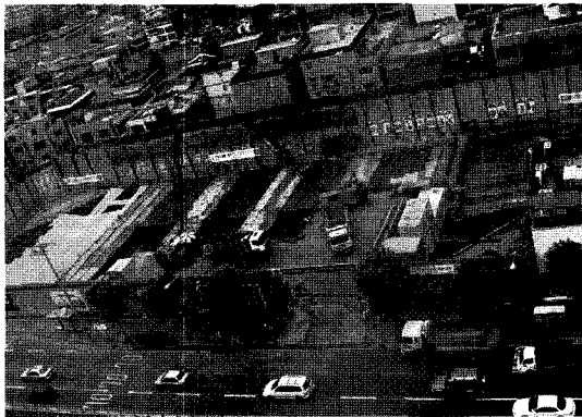
< 가설울타리 및 덮개설치 현황 >
