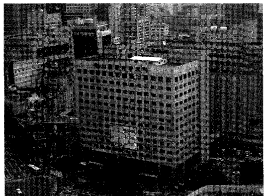
그림 1. 철거 전 기존건물 전경
