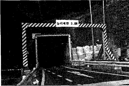
그림 5. 프로텍터 설치
