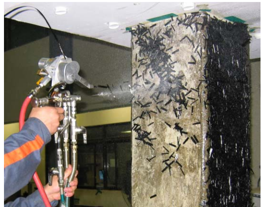
Fig. 6 Sprayed FRP 분사 모습(탄소단섬유)
